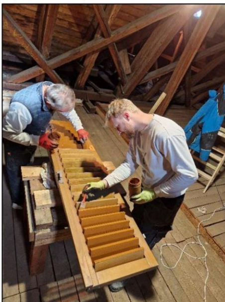
Oprava dřevěných žaluzií v kostele (2024)
