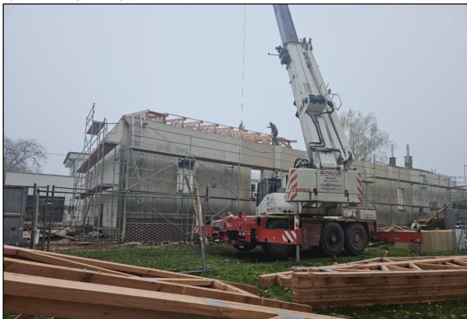
Oprava střechy Orlovny (2024)
